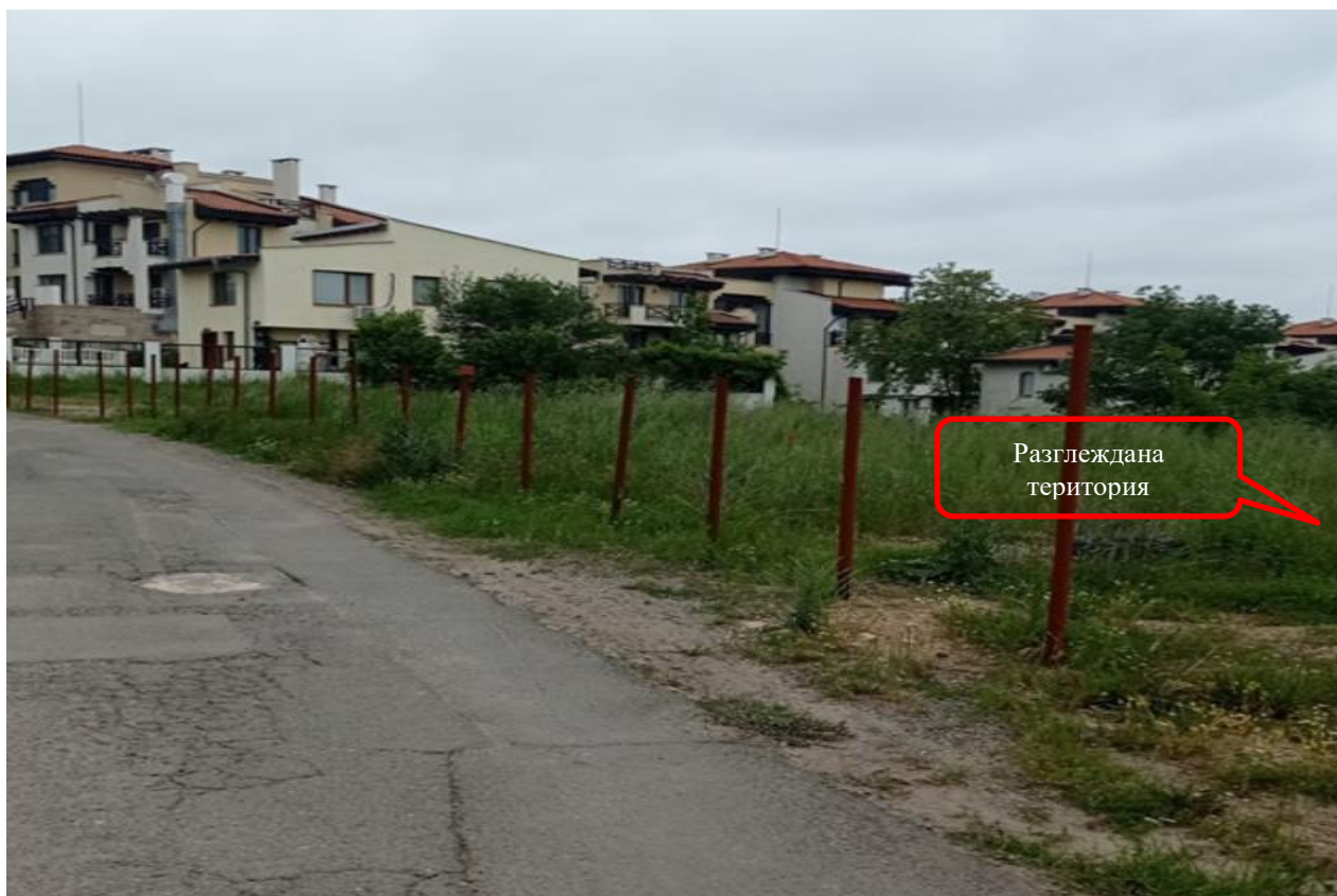
Снимка 1-03: Изглед от съществуващ път от север
